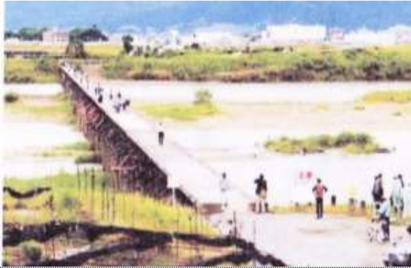
▲川が溢れると流され、水が引くと元に戻る柔構造で長さ日本一の木橋、木津川流れ橋。台風一過で水嵩が増える。時代劇用ロケでも有名。
